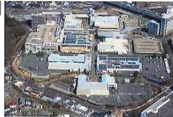
現場全景写真
